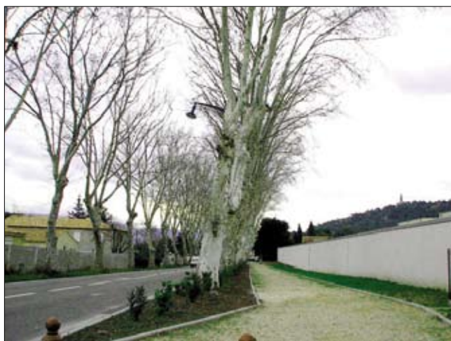
Travaux chemin des collégiens
