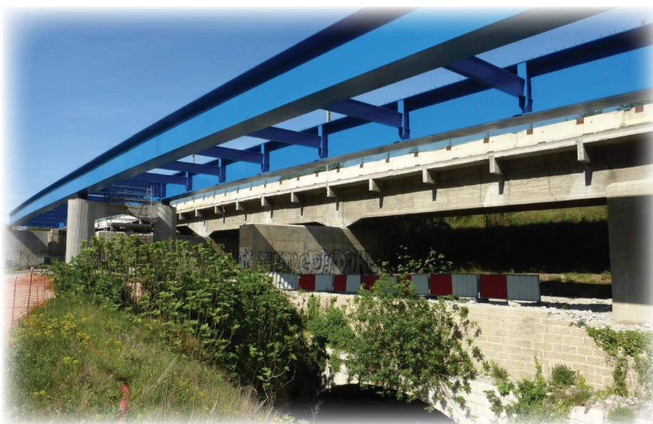
*Les deux poutres métalliques avant la pose des dalles de roulement.
