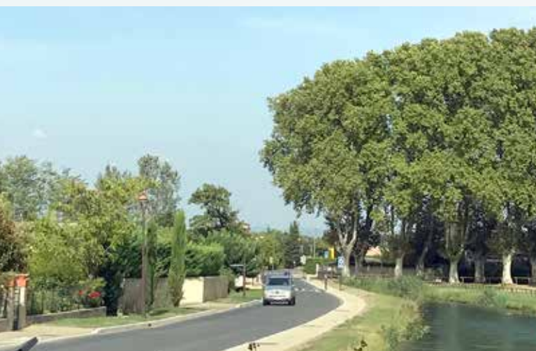
AVENUE DU MOULIN chemin piétonnier le long du Canal et mise en place d'un passage piéton surélevé au niveau du cabinet médical.
