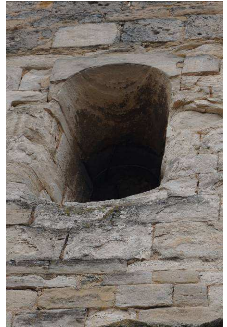
Baie du 1 er étage
