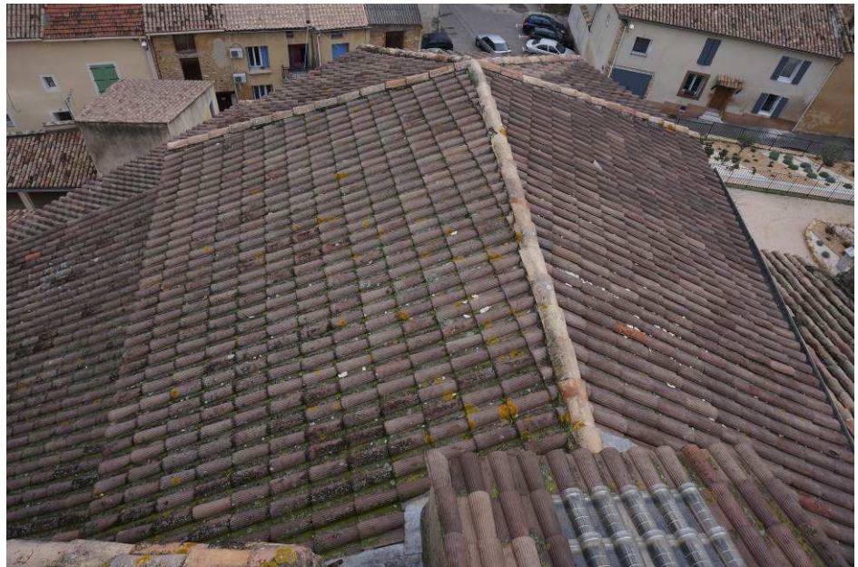
Vue montrant la couverture du chœur
