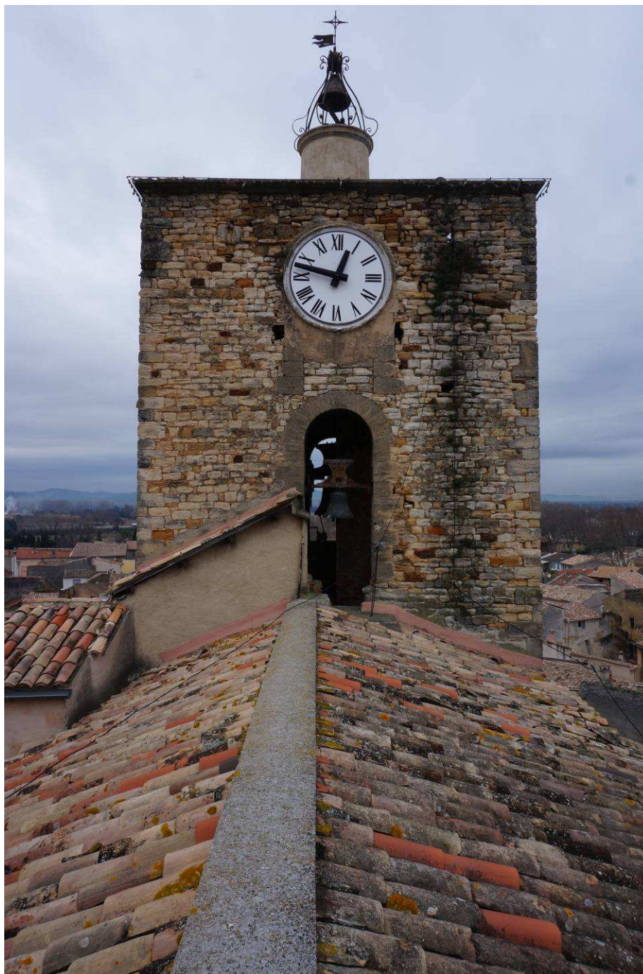
Vue du clocher depuis l'est. On distingue très nettement les zones de ruissellement des eaux évacuées par l'exutoire de la terrasse à droite (l'exutoire de gauche est inactif en fonctionnement normal)
