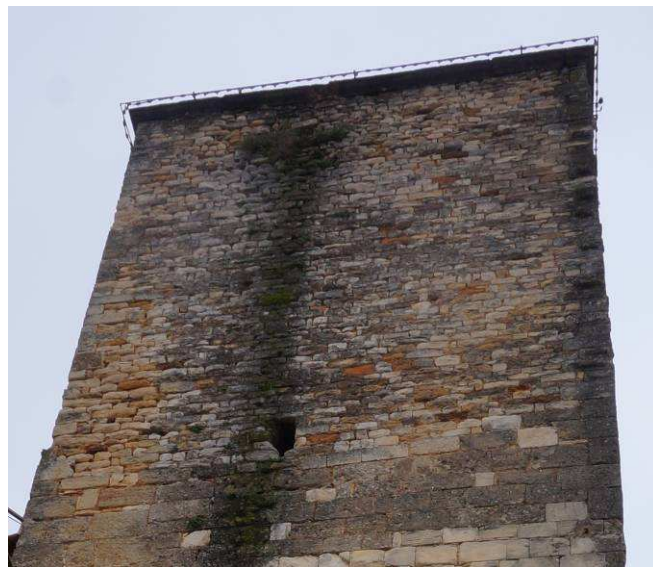
Vues du clocher depuis le sud-ouest (vue de gauche) et le nord (vue de droite). On distingue très nettement les zones de ruissellement des eaux évacuées par les exutoires de la terrasse.
