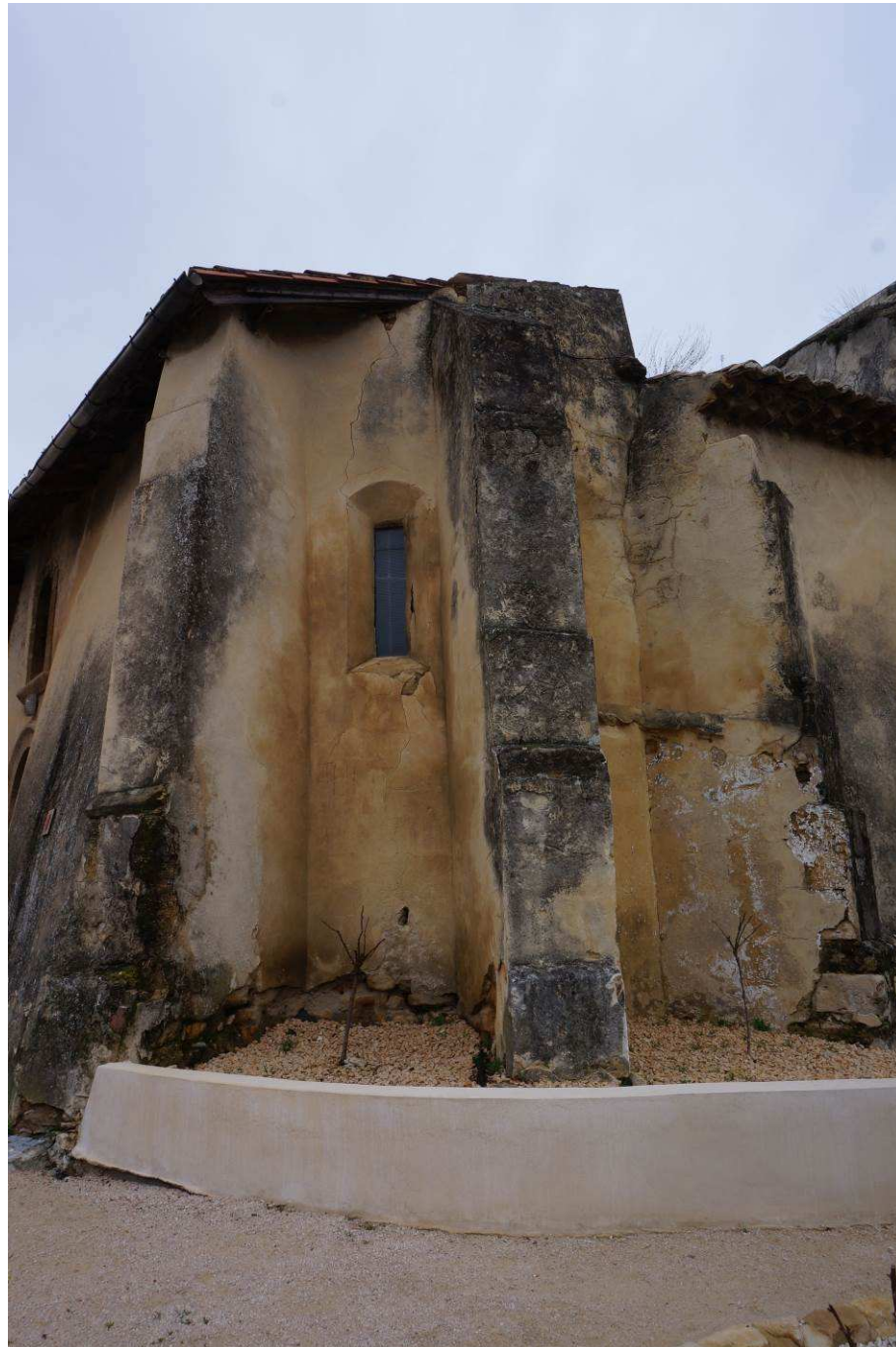
Vue montrant la chapelle sud depuis le nord-est
