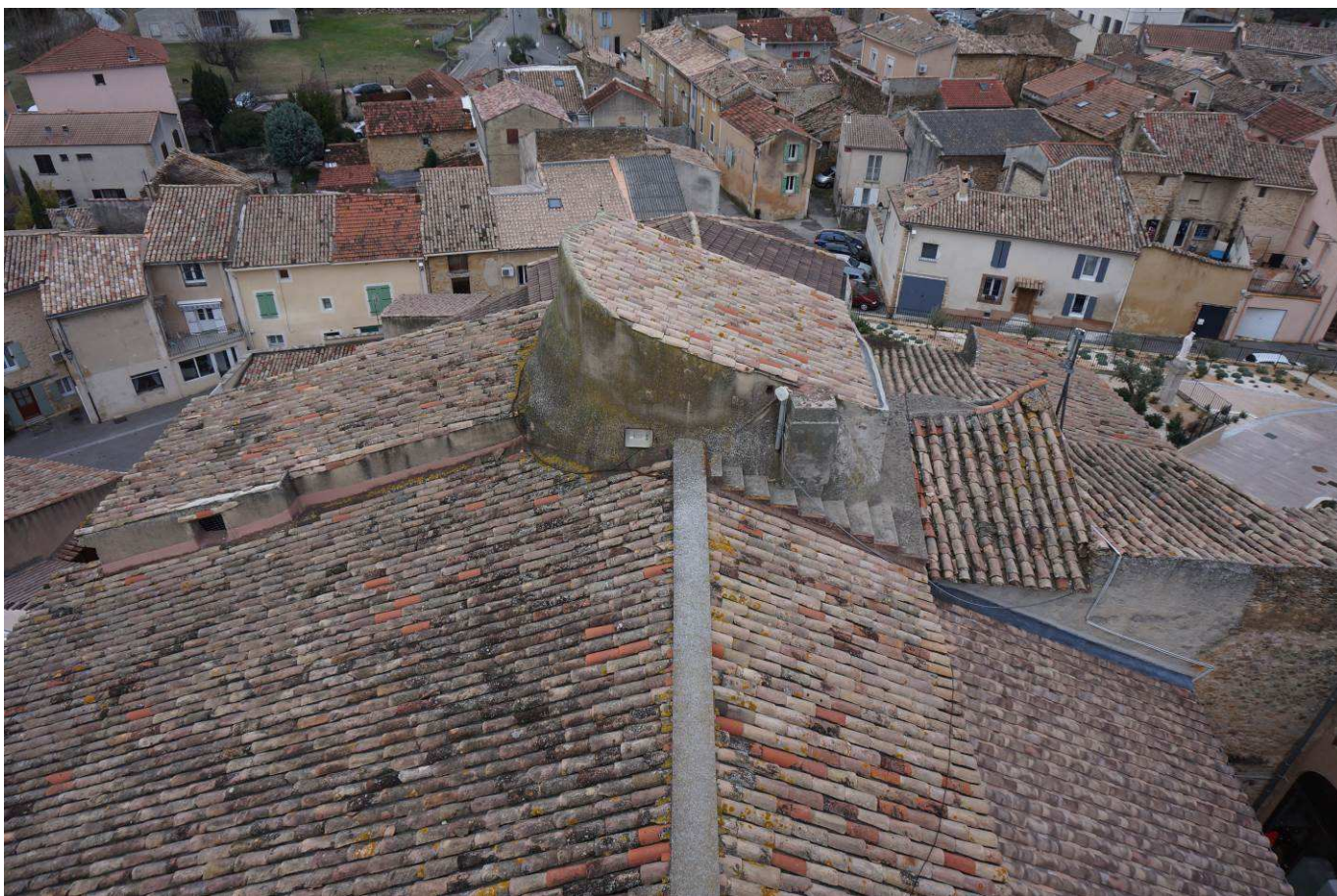
Couvertures de la nef et des bas-côtés vues vers l'est (en haut) et vers le nord (en bas) – On distingue les vestiges de la tour lanterne démolie à la révolution. La couverture de couleur différente sur la droite de la vue du haut, est celle des chapelles sud.
