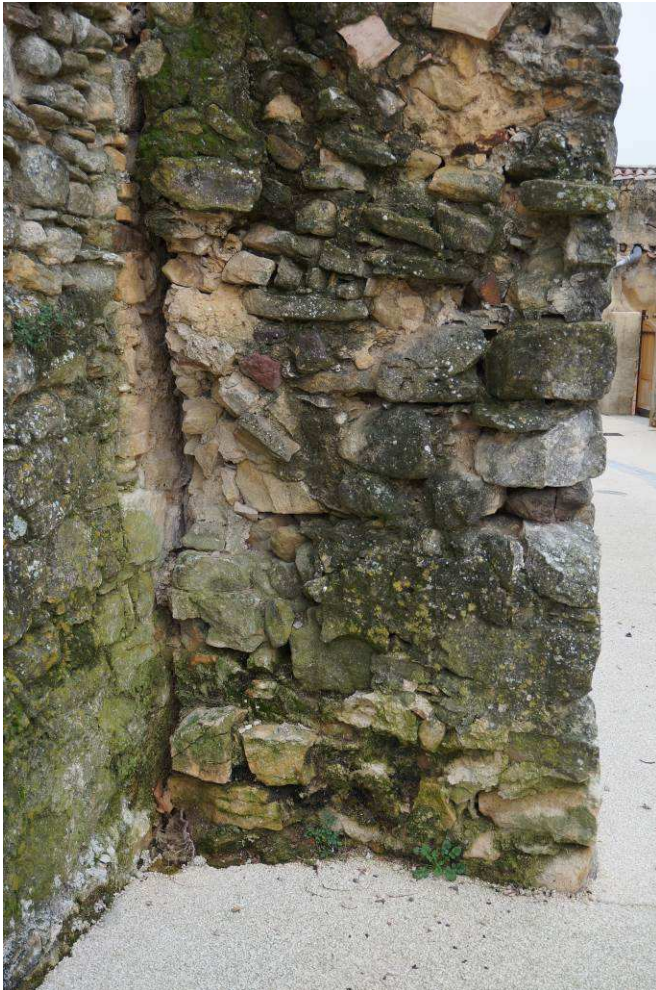
Vue montrant l'adossement de l'avant dernière chapelle nord sur le gouttereau de la chapelle du transept
