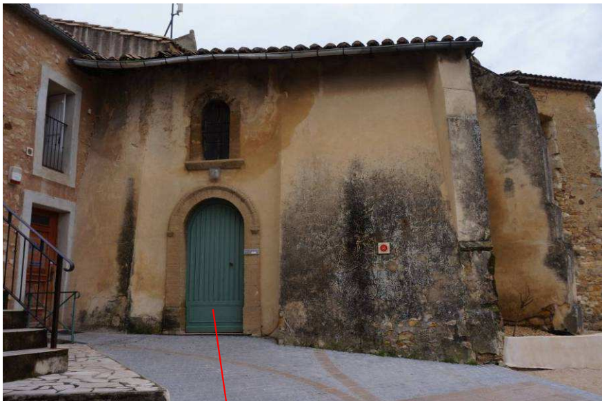
Accès de l'église, créé au sud-est au 19 ème siècle
