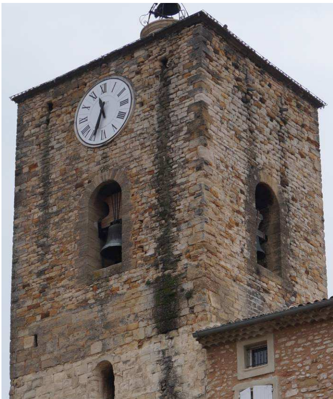
Vues du clocher depuis le sud-ouest (vue de gauche) et le nord (vue de droite). On distingue très nettement les zones de ruissellement des eaux évacuées par les exutoires de la terrasse.
