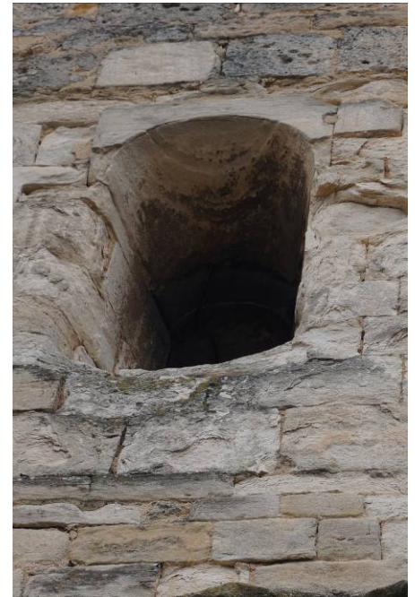
Baie du 1 er étage
