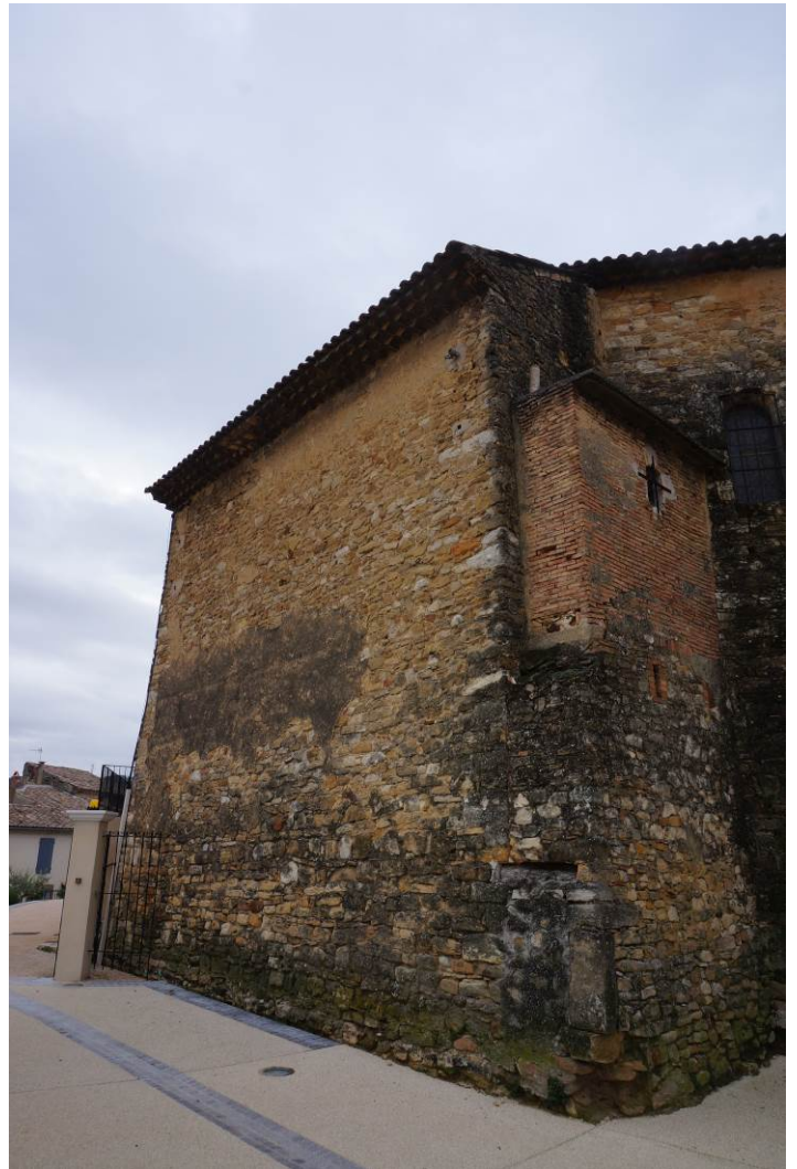
Vue montrant la sacristie depuis le nord-ouest
