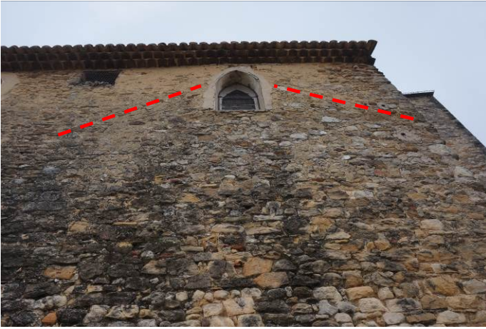
Vue des élévations nord des chapelles. En rouge l'ancienne arase supérieure du mur
