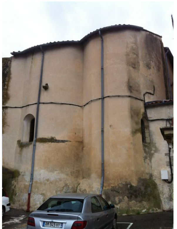
Eglise de Sarrians – Abside du chœur et de la chapelle alignée nord – Élévation extérieure (l'élévation romane a été surélevée probablement à l'époque moderne)
