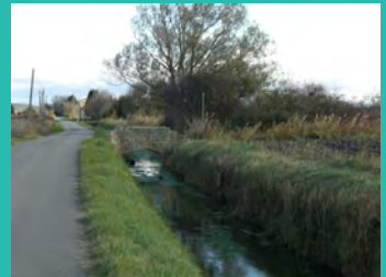
Pont sur la Mayre des Paluds
