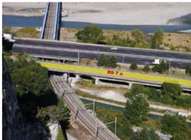
Construit à partir de 1940 au-dessus des voies ferrées pour supprimer le passage à niveau, le pont actuel comporte 7 travées et mesure une centaine de mètres. Réalisé en béton armé avec des matériaux de médiocre qualité, cet ouvrage est inadapté aux charges routières actuelles. Il va être remplacé par un pont mixte métal-béton de longueur équivalente comportant 2 grandes travées.
