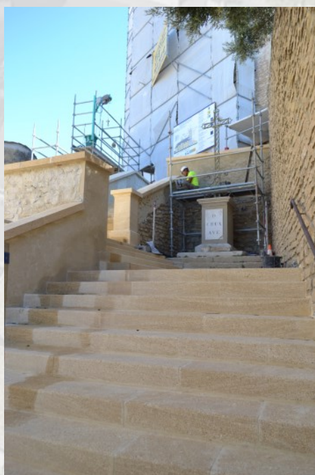
Travaux de restauration de l'église Saint-Pierre. Site clunisien classé.
