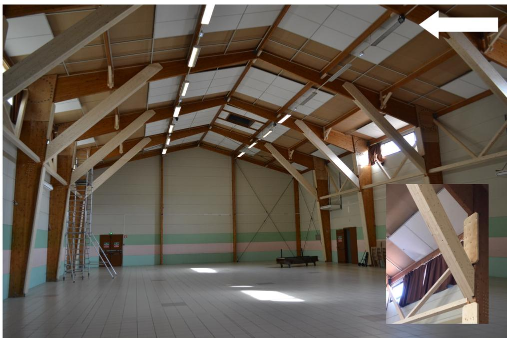
**La salle des fêtes** a été fermée au public fin 2019 suite à la découverte d'une faiblesse structurelle risquant d'impacter directement la sécurité des utilisateurs. Après diagnostic, la charpente a dû être renforcée. L'installation prochaine d'un faux-plafond permettra d'améliorer le rendement énergétique du bâtiment. Il sera également isolé et recevra un nouvel éclairage LED et une nouvelle sono.
