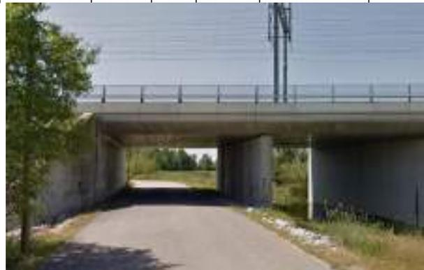
Ouvrages hydraulique permettant au Riou de traverser l'A7 (à gauche) et la LGV (à droite)
