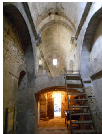
Vue de l'intérieur de la Chapelle Sainte Luce
