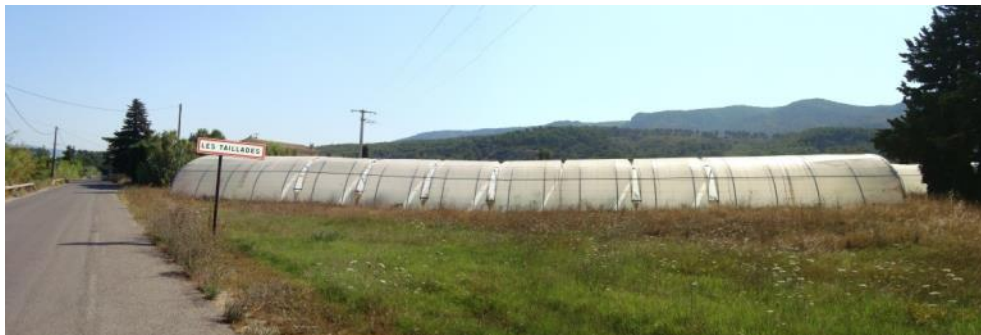
Serres de cultures maraîchères - Chemin des Croix Rouges
