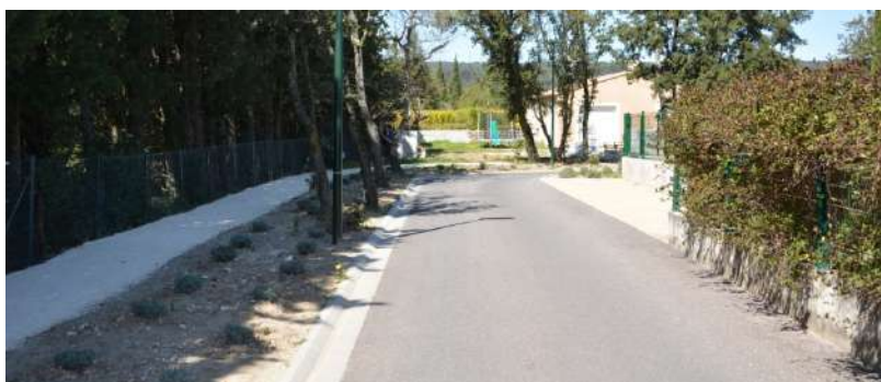
Trottoirs et voies piétonnes en sites propres dans des lotissements.
