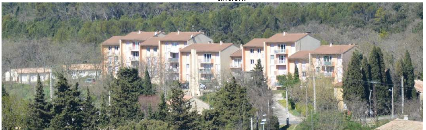
Le groupe de 31 logements HLM en entrée de village.
