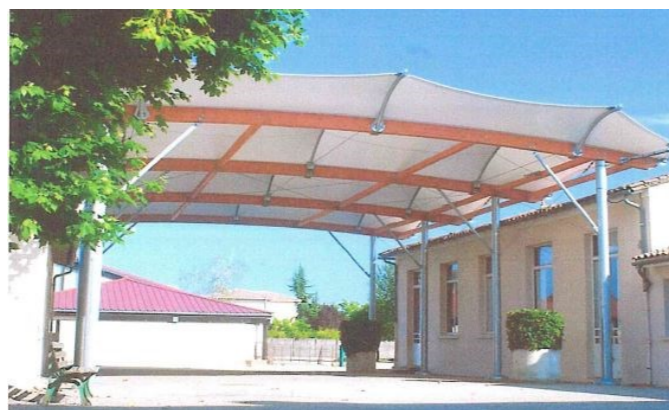
Exemple de réalisation
