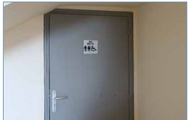
Signalétique sur la porte des toilettes de la mairie
