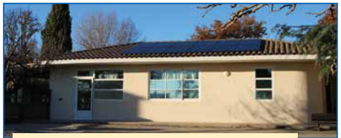
Les panneaux photovoltaïques sur le toit de l'école communale
