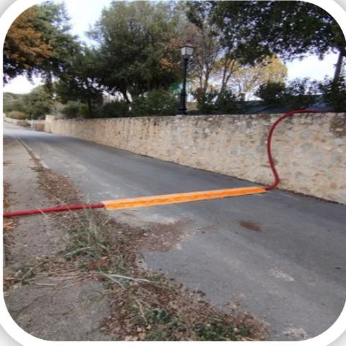
Mis en place d'une alimentation électrique provisoire pour le chantier du futur hangar technique.
