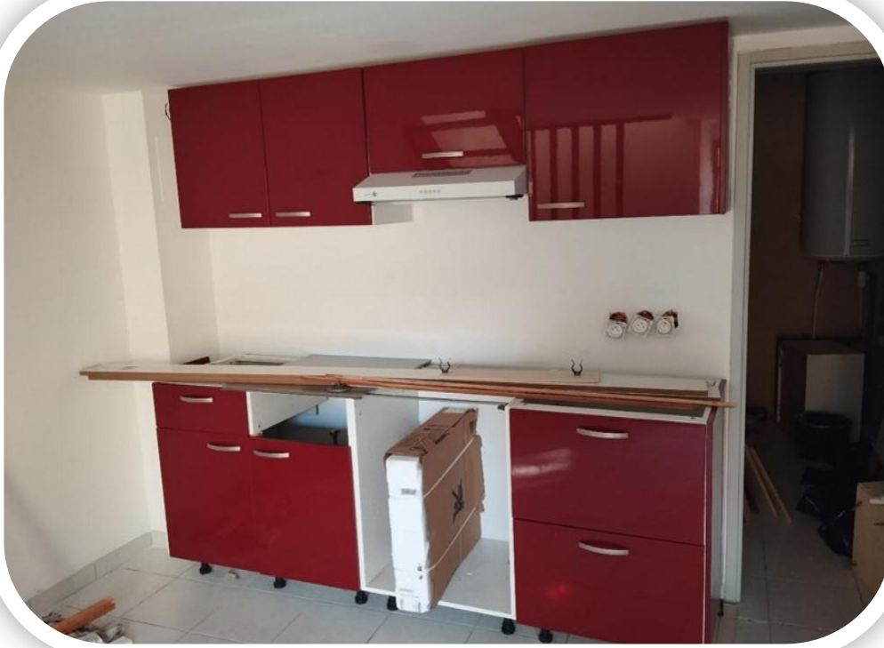
Réfection complète du studio situé 11 rue des jardins.
