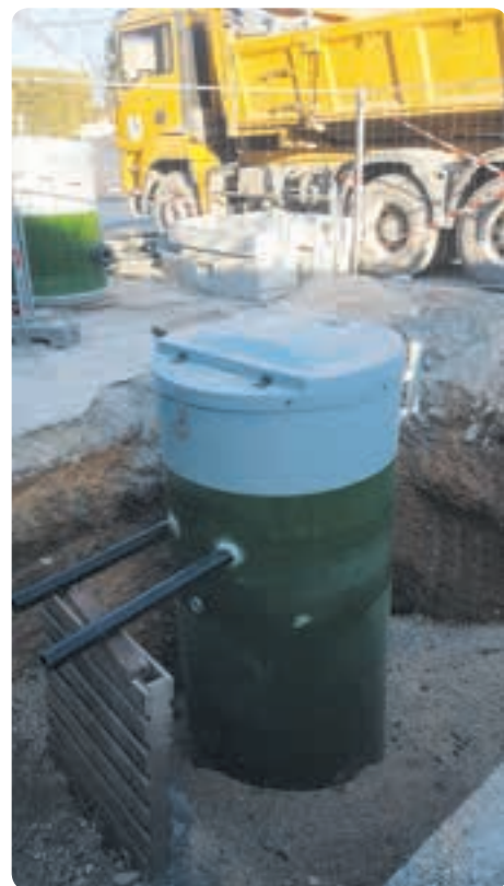
Le collecteur qui va centraliser les rejets
