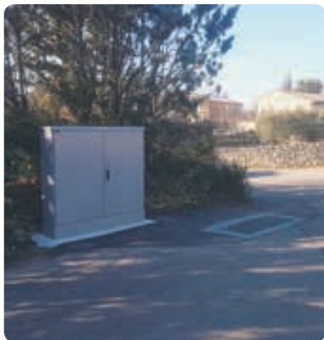
Une armoire de connexion installée récemment au départ du chemin du Chat
