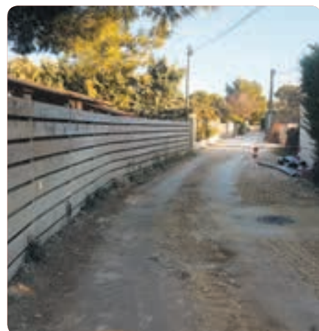
Chemin en attente du revêtement final
