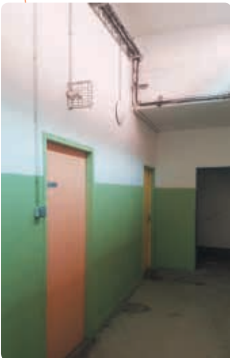
Un des détecteurs de présence installé dans le couloir
