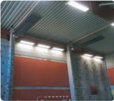
2 des 8 radiants installés au plafond du gymnase
