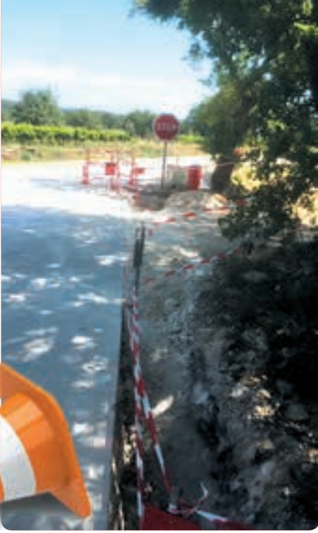
Le chantier au Chemin du Grand Camp
