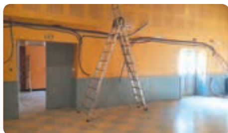
Mise en place des canalisations de chauffage
