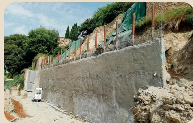
Les barbacanes et des drains verticaux sont mises en place pour permettre la récupération des eaux de ruissellement.
