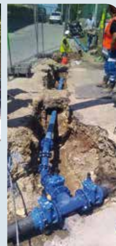
Travaux maillage communal APRÈS
