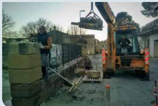
le choix d'une structure «aérée» s'imposait. Si la partie métallique a été réalisée par un professionnel, les fondations et la maçonnerie ont été réalisées par nos agents et des élus, tout comme la rénovation de l'entrée de la cour.
