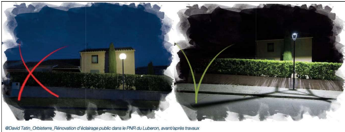
Exemple d'éclairage avant et après travaux dans le PNR du Lubéron (second niveau bien moins impacté)
